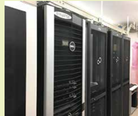
写真: サーバ室(電子カルテ・パソコン)
